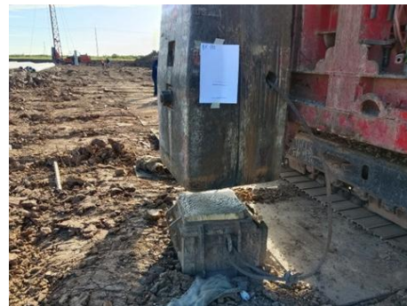
ภาพที่ 2.2-50 การใช้แผ่นไม้รองหัวเสาเข็มลดเสียงดัง
