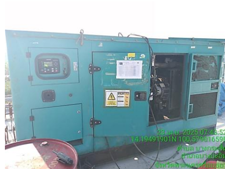
ภาพที่ 2.2-14 การปิดครอบเครื่องจักรเพื่อลดระดับเสียง
