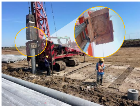
ภาพที่ 2.2-50 การใช้แผ่นไม้รองหัวเสาเข็มลดเสียงดัง
